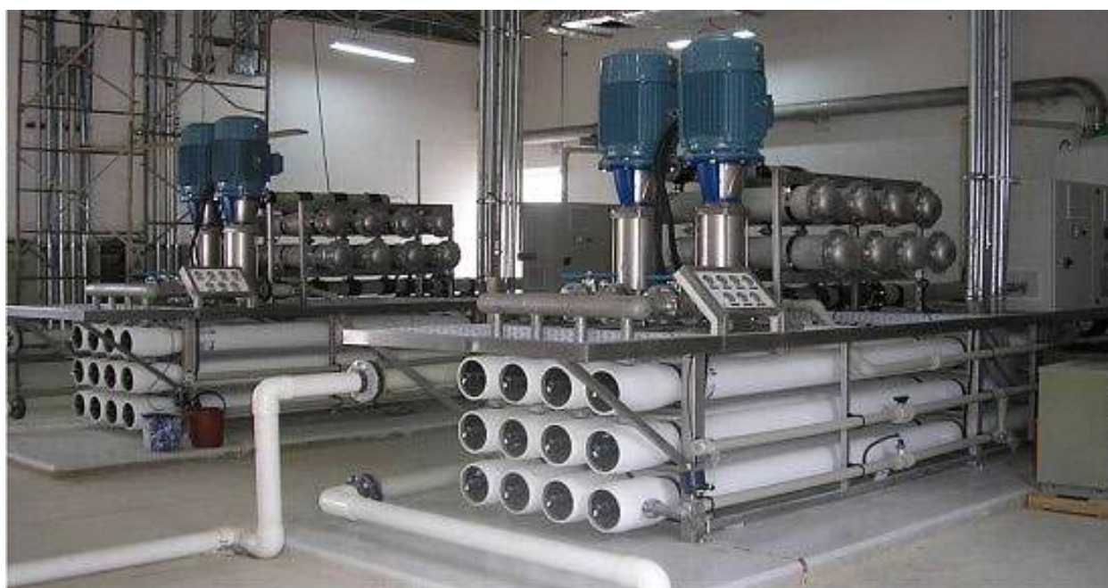
Рис. 19. Установки заворотного осмосу компанії Лакта-Сервіс [22]
