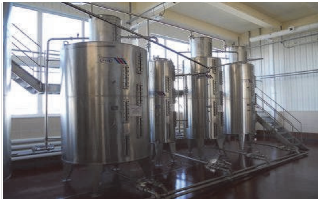
Рис. 8.9. Установка приготування водно-спиртової суміші
