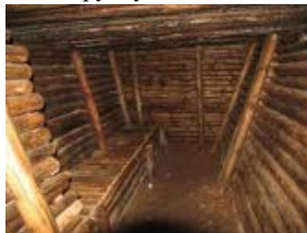
Рисунок 74 – укриття типу бліндаж.
