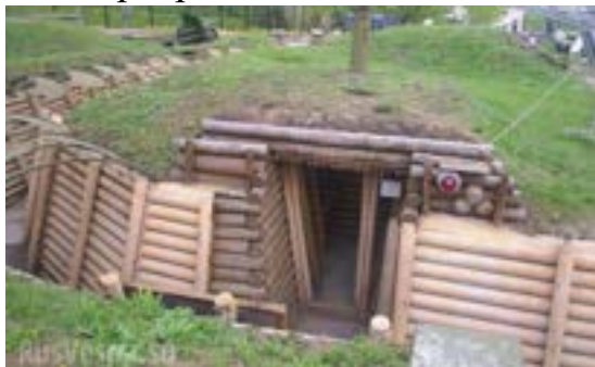
Рисунок 74 – укриття типу бліндаж.
