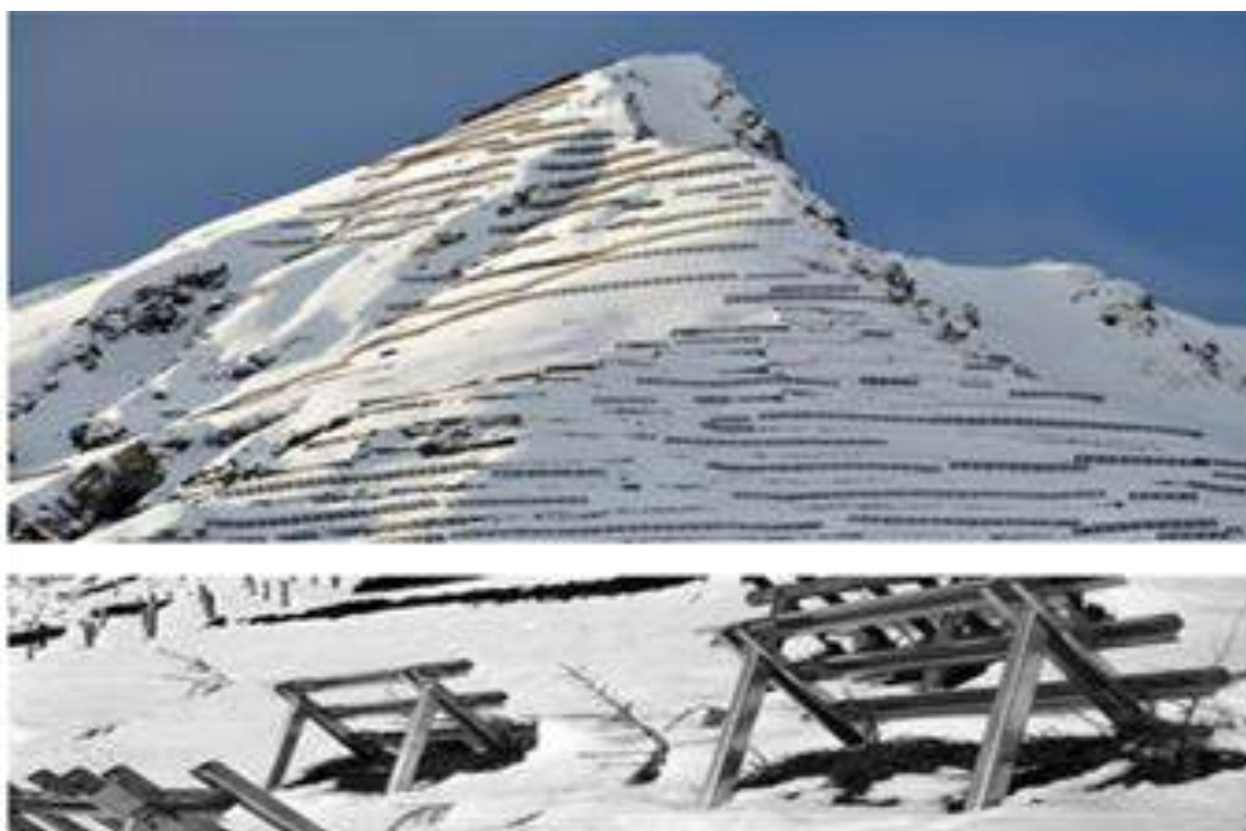
Рисунок 7.7 – Сучасні протилавинні бар'єри на горі Шіахорн над містом Давос в східній частині Швейцарії
