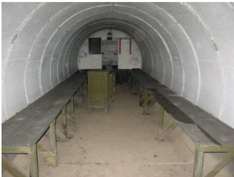
Рисунок 6.8 – Швидкостпуруджувана захисна споруда цивільного захисту із залізобетонних кілець
