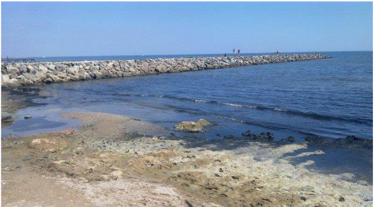
Рисунок 7.10 – Кріплення берегу кам'яно-накидними бунами
