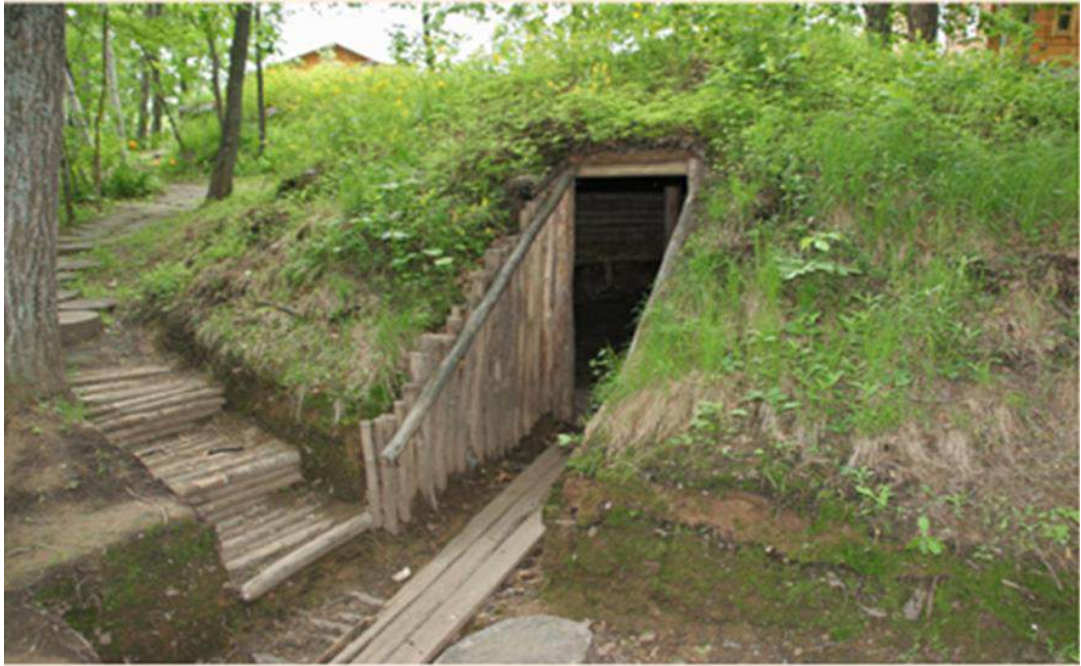
Рисунок 6.11 – Перекрита щілина — найпростіше укриття
