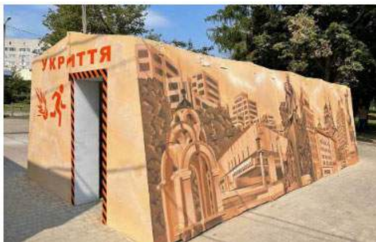
Рис. 9.57. Укриття на зупинці громадського транспорту, м. Харків
