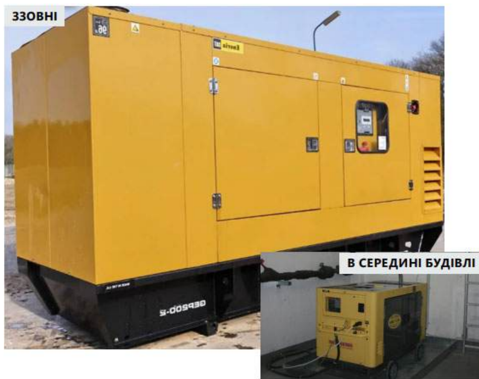
Рис. 9.15. Розміщення ДЕС безпосередньо в межах захисної будівлі або зовні (на вулиці)
