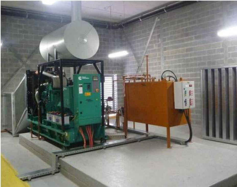
Рис. 9.13. Розміщення ДЕС безпосередньо в межах захисної будівлі
