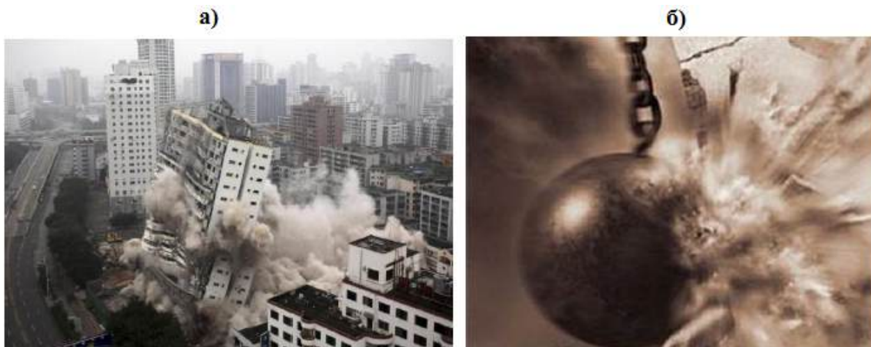
Рис. 10.13. Обвалення нестійких конструкцій будівель: а – за допомогою вибуху; б – за допомогою шар-баби
