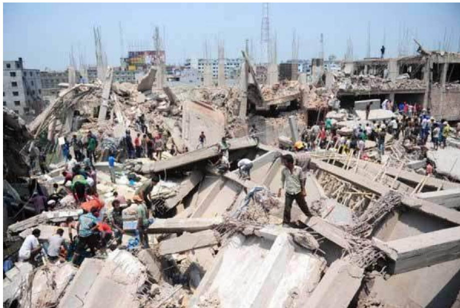
Рисунок 4.9 – Повне руйнування будівлі
