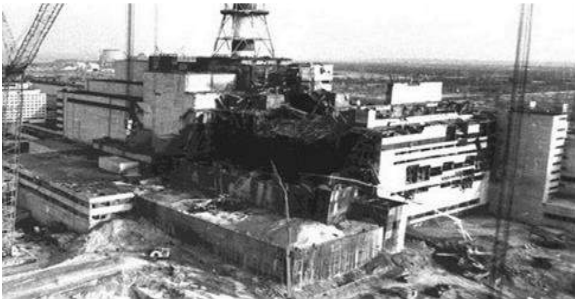
Рисунок 1.6 – Вид зруйнованої споруди 4-го енергоблоку,
