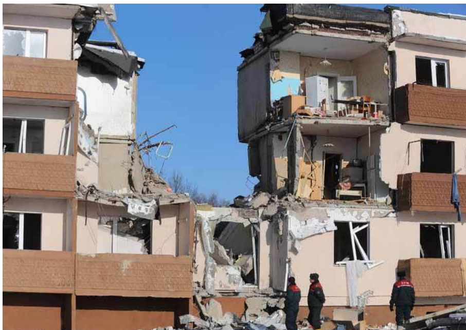
Рисунок 4.8 – Сильне руйнування будівлі
