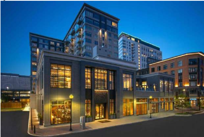
Рисунок 10.6 – Приміський готель Row at Assembly Row біля станції Бостону (фото з вільних джерел)
