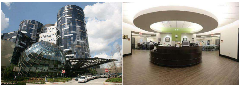
Рисунок 9.3 – Будівля лікарні Вінні Палмера в Орландо, Флорида (фото з вільних джерел)
