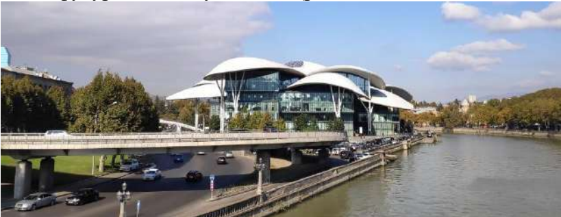
Рисунок 11.14 – Будівля юстиції в Грузії (фото з вільних джерел)
