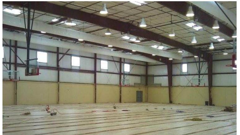
Загальний вид сталевго каркасу виробничої будівлі.
