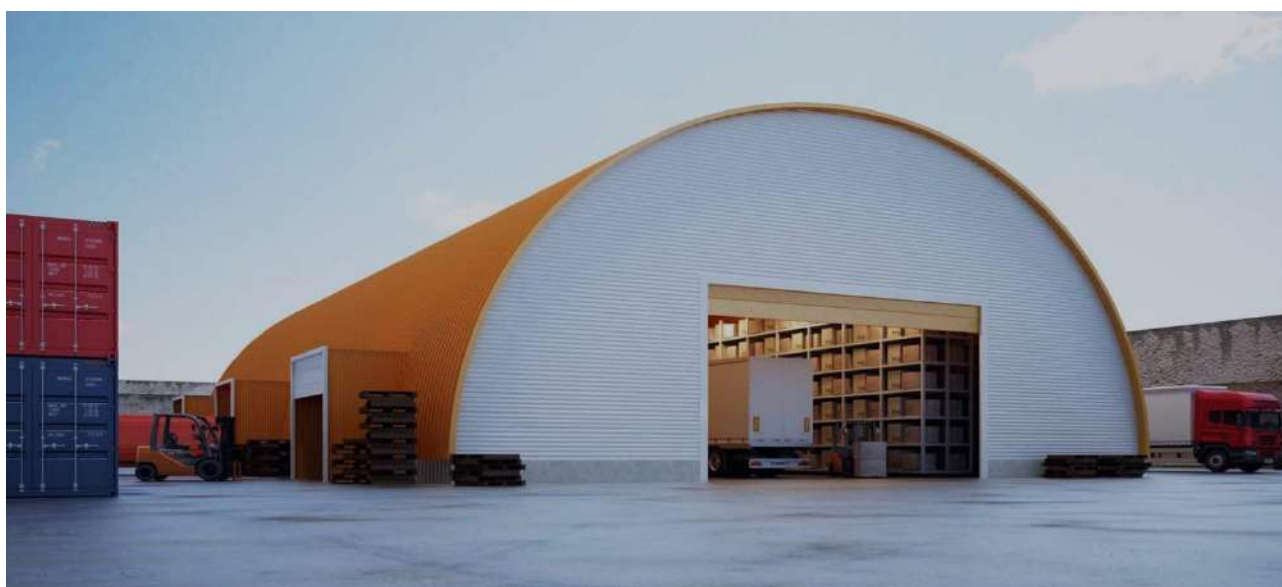
Рис. 2. Безкаркасне овочесховище
